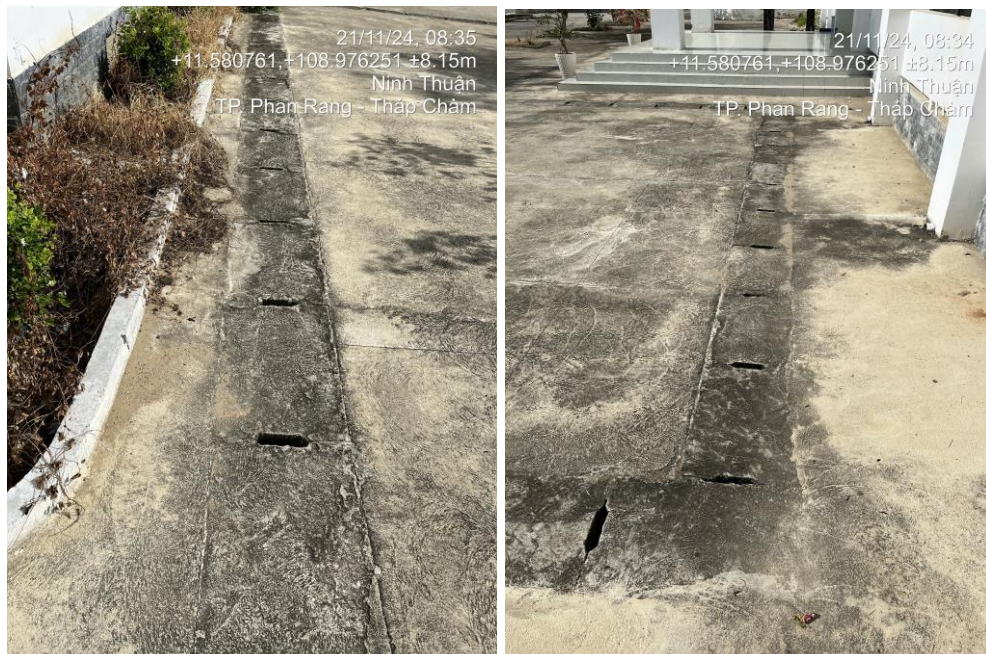
Hình 4.2. Mương thoát nước mưa hiện hữu của Dự án
