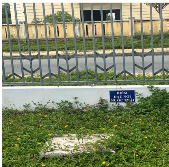
Hình 3-9: Bể khử trùng
